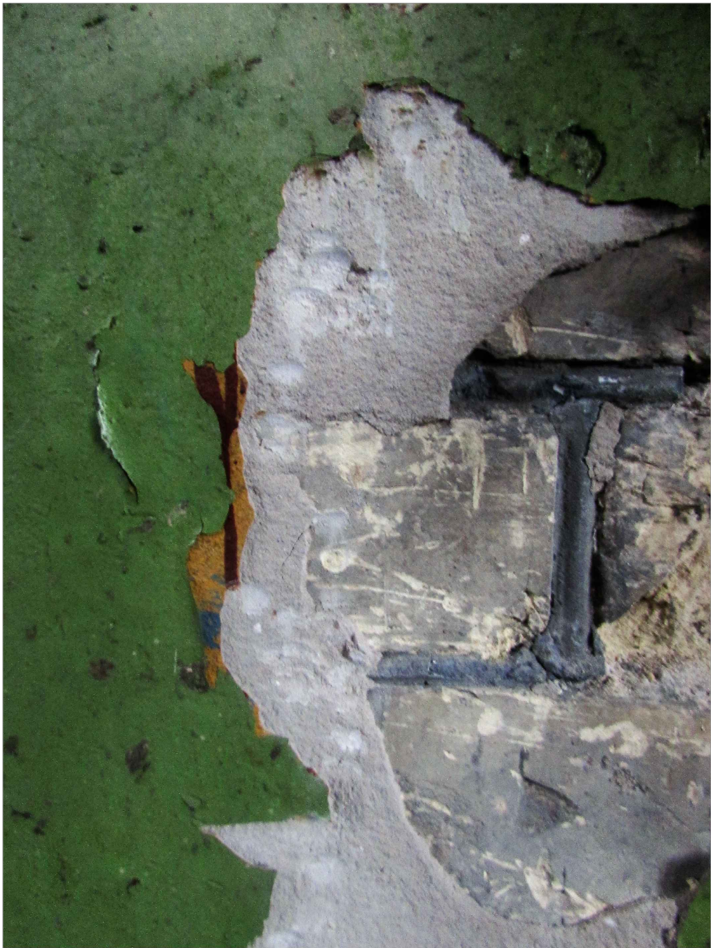
Zondāža 2. Lokāli nelielos laukumos remontu laikā uzstrādāts cementa javas apmetums, kurš labi atdalās no ģieģeļa.
